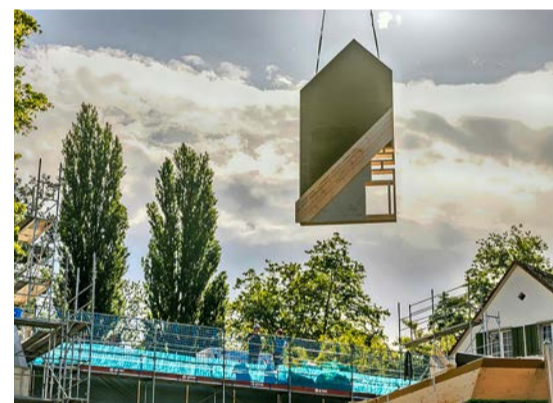
Präzise vorgefertigte Bauelemente wurden zur richtigen Zeit auf der Baustelle angeliefert.
